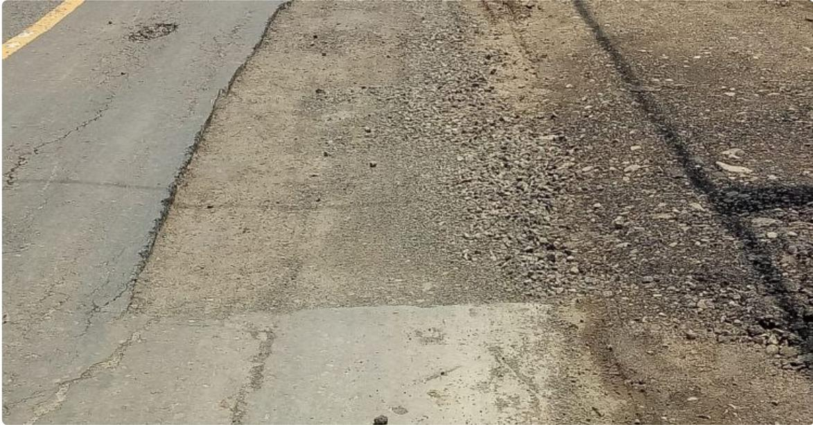
"Galian tanah pengerjaan jaringan pipa PDAM mengakibatkan jalan becek saat terjadi hujan dan debu pada saat kering. Diperparah, pengaliran aliran pipa ketika dilakukan penimbunan tidak dipadatkan hanya ditimbun biasa. Sehingga, sisa - sisa tanah masih banyak yang berserakan di jalan," ujar salah seorang warga setempat,
