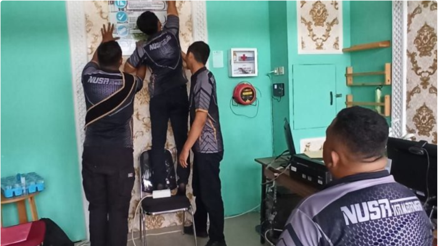
Kabapas dan Staff Renovasi Ruang Baladewa
